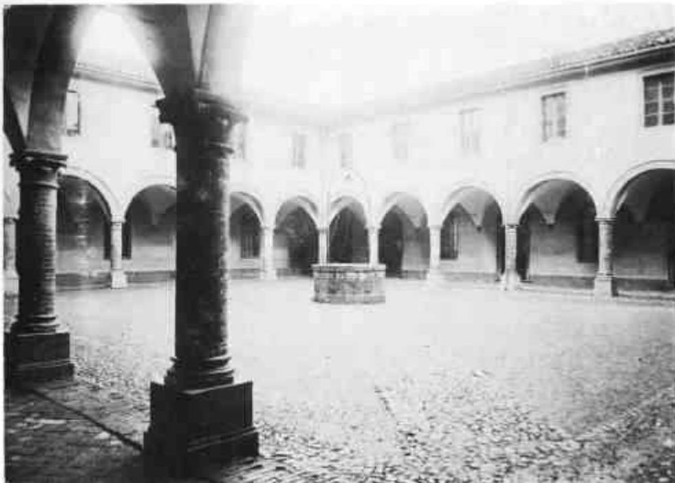
Cortile interno dell'ex convento dei frati di S. Francesco, dal 1879 sede delle scuole comunali.
